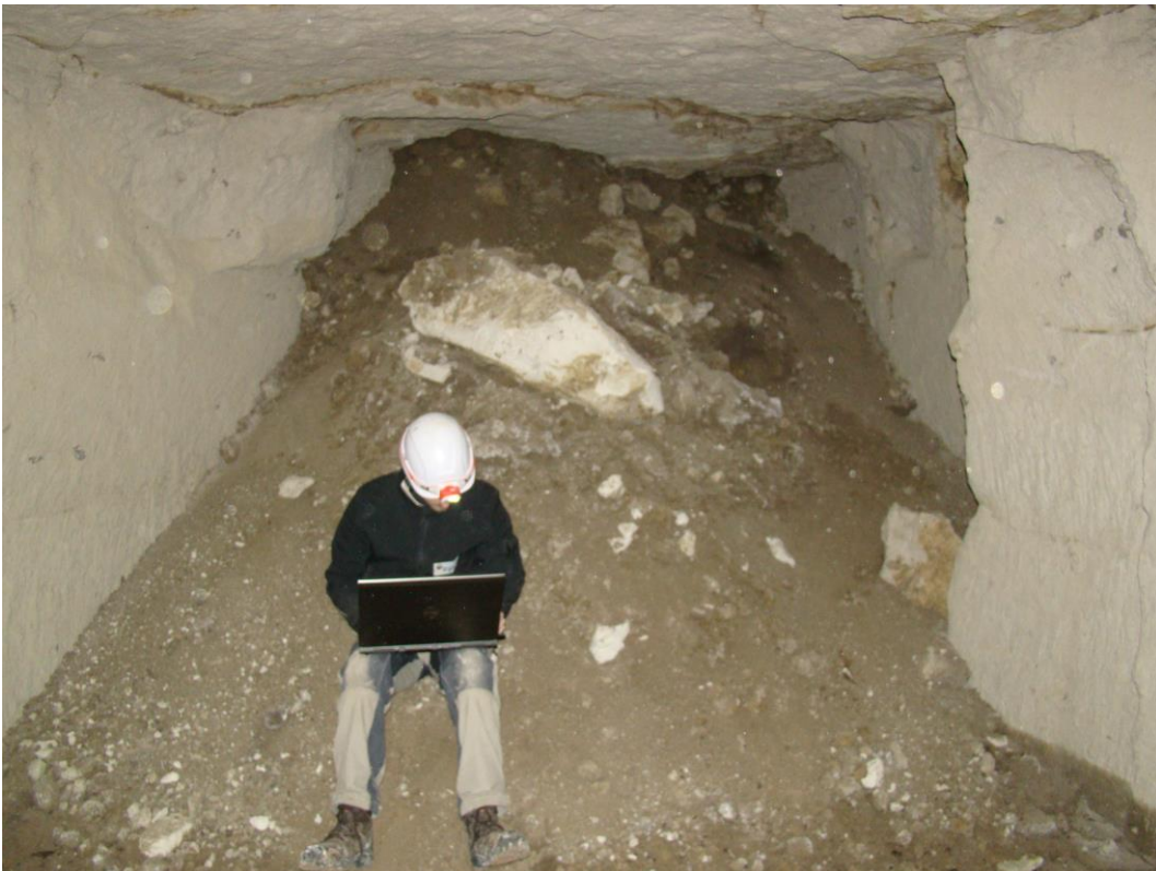
Illustration 12 : Secteur sud – cône d'éboulis situé sous le chemin communal qui relie la RD9 au lieu-dit « Le Cauchis »
