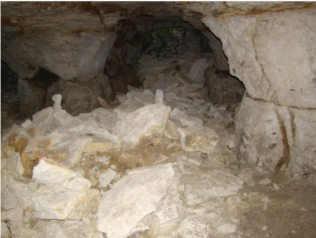
Illustration 7 : Secteur nord – large chute du 1 er banc de toit conditionné par une diaclase naturelle argilisée
