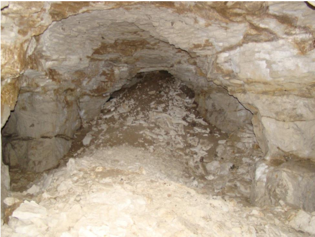
Illustration 9 : Secteur nord – fontis débouchant au jour sous le talus de la RD9, à l'extrémité nord-est de la carrière souterraine
