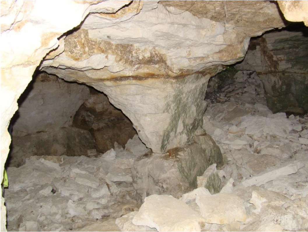
Illustration 6 : Secteur nord – chutes de toit et pilier en diabolo. Les mousses vertes sur les piliers témoignent d'une hygrométrie élevée
